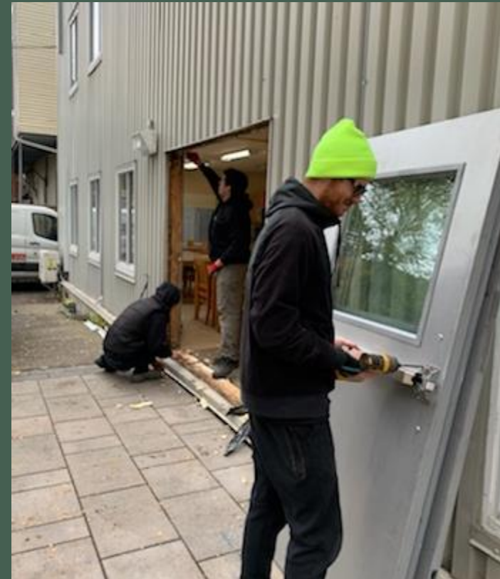
Portes extérieures changées
